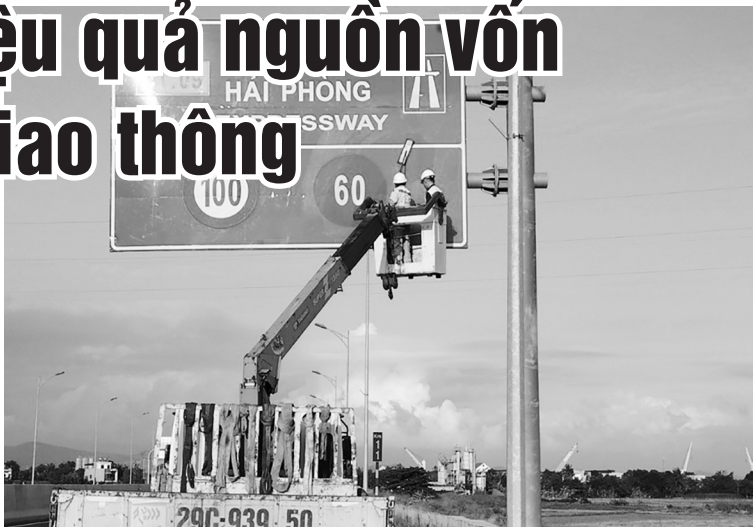
Vệ sinh hệ thống biển báo trên tuyến cao tốc dọc tỉnh.
