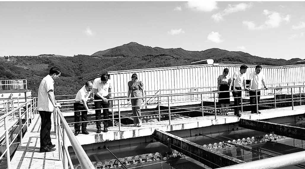
Đoàn giám sát của HĐND TP Cẩm Phả kiểm tra hoạt động cung cấp nước sinh hoạt tại Nhà máy Điện Vong (Công ty CP Nước sạch Quảng Ninh), tháng 9/2023.
