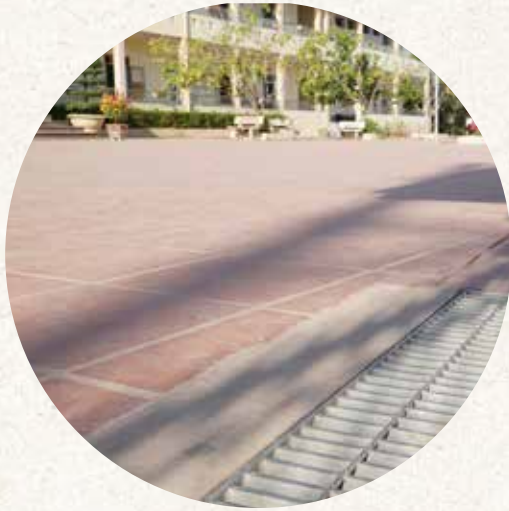
Xây dựng hệ thống thoát nước tại trường Tiểu học & Trung học cơ sở Cẩm Hải
