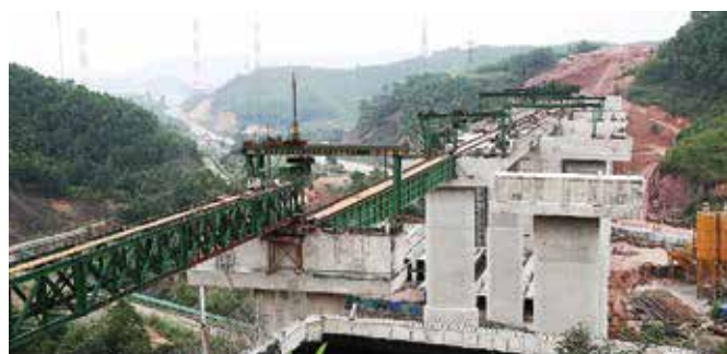
Thi công cầu Cẩm Y 1, cao tốc Hạ Long - Vân Đồn.
