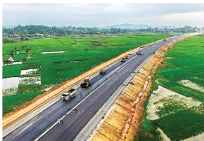
Thi công đường cao tốc Hạ Long - Hải Phòng.
